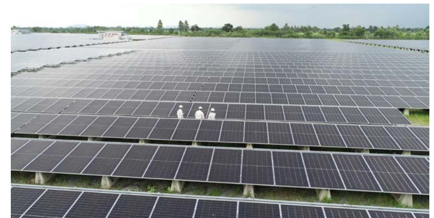
หมายเหตุ : ภาพ Repowering โครงการ SPN
